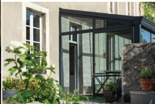
Véranda modèle «Villers», montée d'une part en appui extérieur sur l'habitation existante et d'autre part sur un muret extérieur existant, aménagée en cuisine. Spots intégrés aux chevrons tubulaires.
