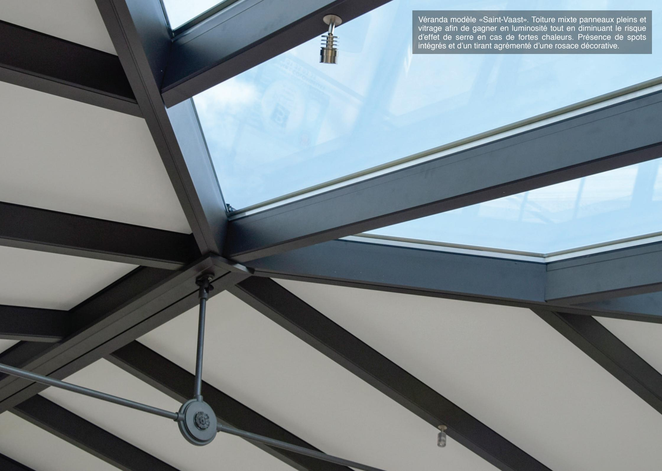
Véranda modèle «Saint-Vaast». Toiture mixte panneaux pleins et vitrage afin de gagner en luminosité tout en diminuant le risque d'effet de serre en cas de fortes chaleurs. Présence de spots intégrés et d'un tirant agrémenté d'une rosace décorative.
