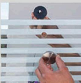
5/ Visser les fixations à œillet avec leur joint sur la dalle de verre côté mur vers le bas
