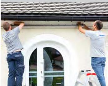
1 / Percer les trous et adapter la fixation en fonction du support puis monter le profilé contre le mur
