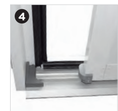
Seuil drainant en aluminium et guide d'attaque
