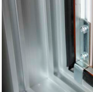
Pose sur dormant de fenêtre – Fixation sans perçage avec pattes métalliques
